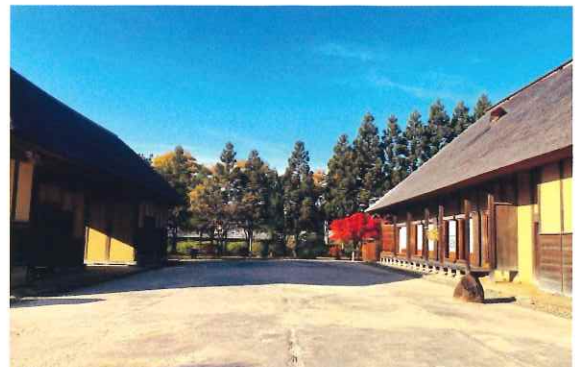
※宮城県：歴史博物館舗装工事 寒冷地施工後8年経過写真
