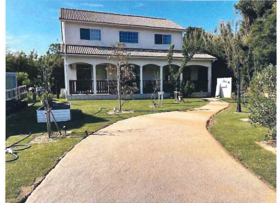
※個人宅外構アプローチ舗装
