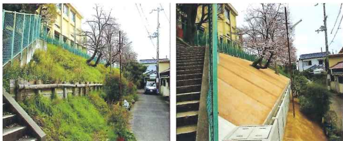
※東大阪市教育委員会：中学校法面改修工事
