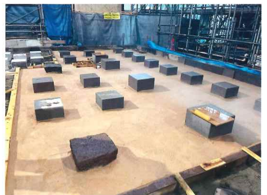
※文化庁、東京都、台東区：浅草寺伝法院客殿及び玄関保存修理工事
