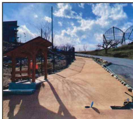
5.規制材や養生材などを片付けて完成。
