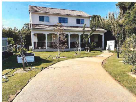
※個人宅外構アプローチ舗装
