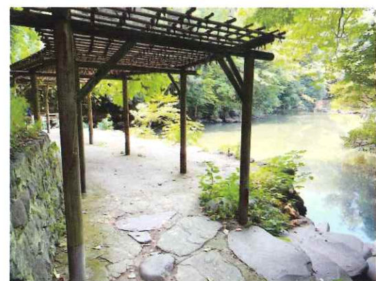
※東京大学：三郎池周遊舗装路 施工後24年経過写真
