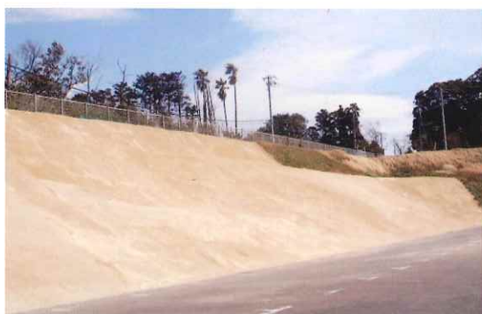
※東京都港湾局:大島空港ターミナル地区緑化改良工事 吹付による法面保護
