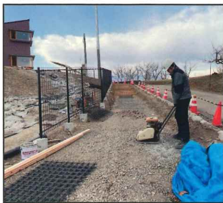
1.草木の除去・抜根など施工場所の下地整生を行った後、路床を転圧し、平らにします。更に条件に合わせた必要な厚さの路盤を形成します。
