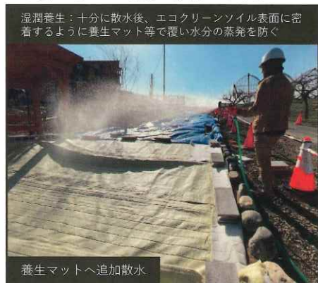
4.必要な強度が出るまで、交通規制等を行い1週間程度養生します。散水した水の凍結や急激な乾燥がおきないように、必要な養生材を用いて養生を行ってください。
