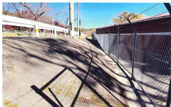
※土地改良区:用水周り防草対策工事 施工後20年経過写真
